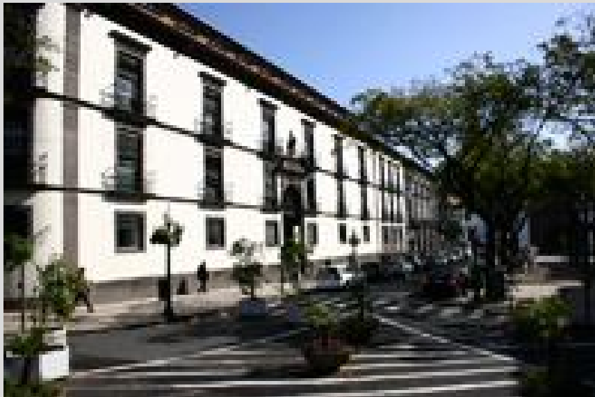
Edifício do Governo Regional da Madeira
